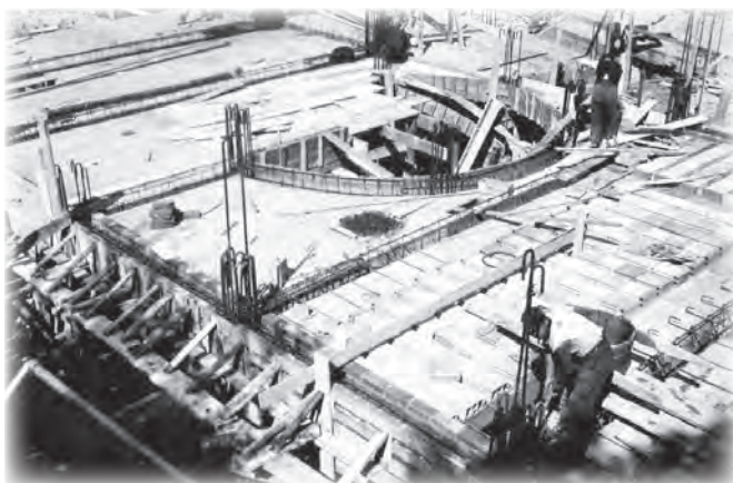
Budowa gmachu przy ul. Gdańskiej
