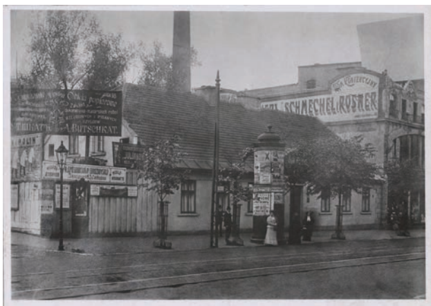
Piotrkowska, róg Przejazd (Tuwima), budynek Zgromadzenia Majstrów Tkackich
