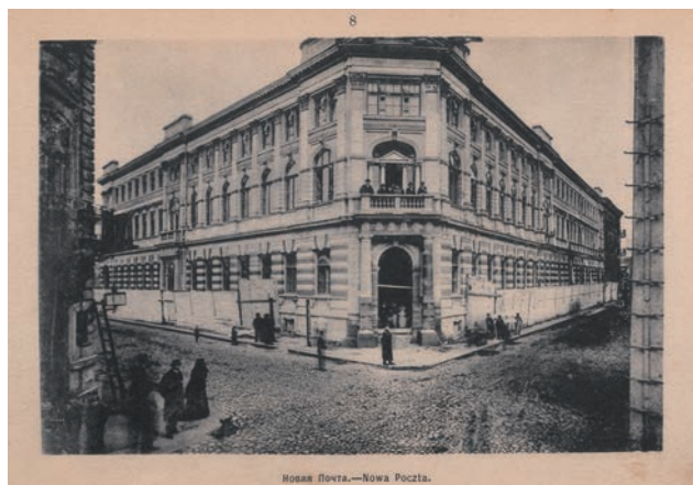
Pocztą Główną, Przejazd (Tuwima), róg Widzewskiej (Kilińskiego)
