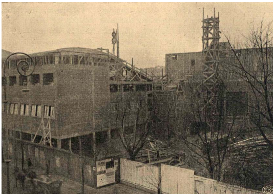
Ogólny widok powstającego gmachu Biblioteki.
