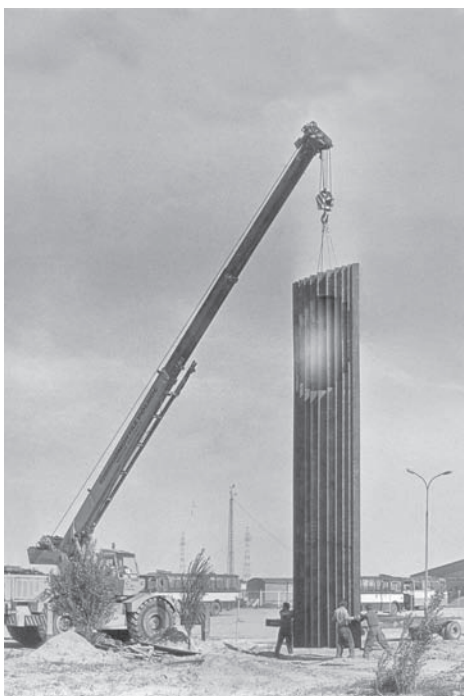
W trakcie montażu "Pomnik Energetyki", stal, 14 m, Kozienice, 1973
